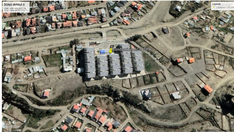
Figura 7 Conjunto habitacional Eco-Spa
