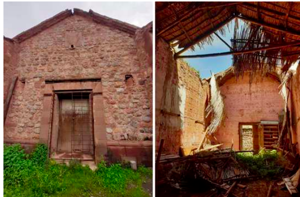
Figura 11. Estado actual del ingreso y cobertura del polvorín San Carlos
