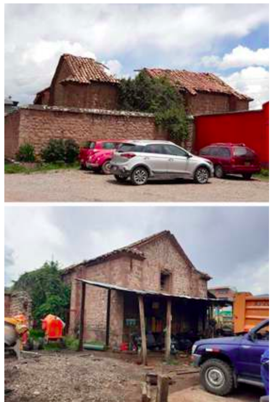
Figura 10. Imágenes del estado actual del exterior del polvorín San Carlos
