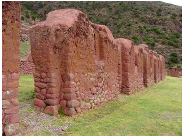
Figura 3. Utilización de los elementos líticos en los cimientos y sobrecimientos de los muros
