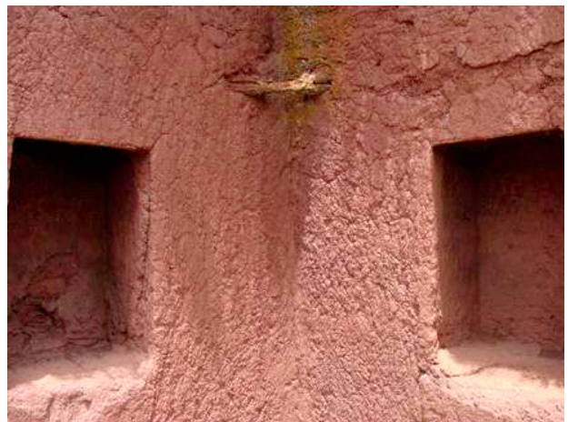
Figura 4. Refuerzo de llaves de madera en las uniones de los muros
