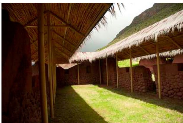
Figura 20. Recinto 1, cobertura metálica instalada de forma aislada a los muros
