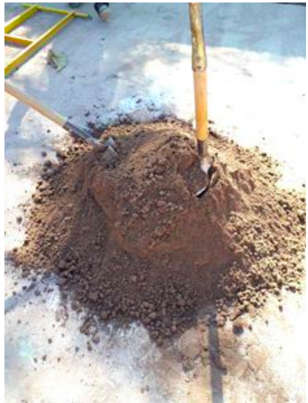
Figura 6. Mezclado del suelo y estabilizantes
