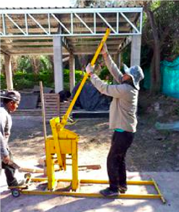
Figura 8. Compactación por medio del accionamiento del sistema de palancas
