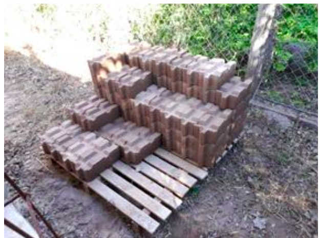
Figura 10. Acopio del BSC sobre pallets
