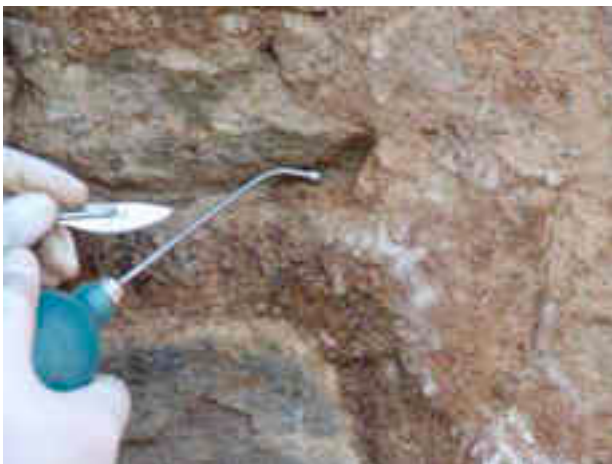
Figura 32. Consolidación con carga por inyección de las zonas con espacios vacíos de los revoques
