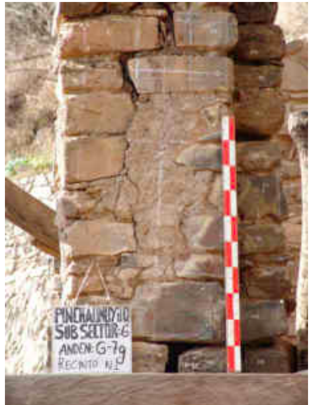
Figura 7. Fragmento grande de revoque ubicado en la cara exterior del muro sur
