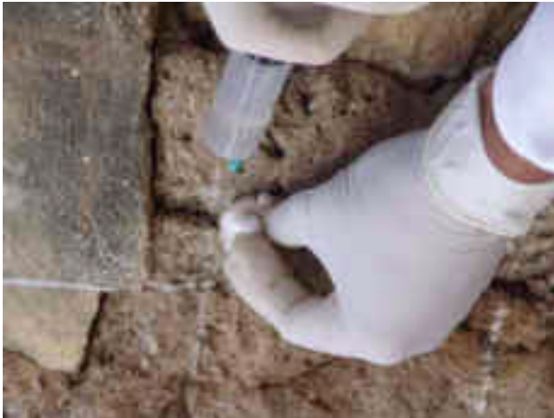
Figura 19. Haciendo uso de hipodérmicas se aplicó consolidante en los fragmentos de revoque de barro
