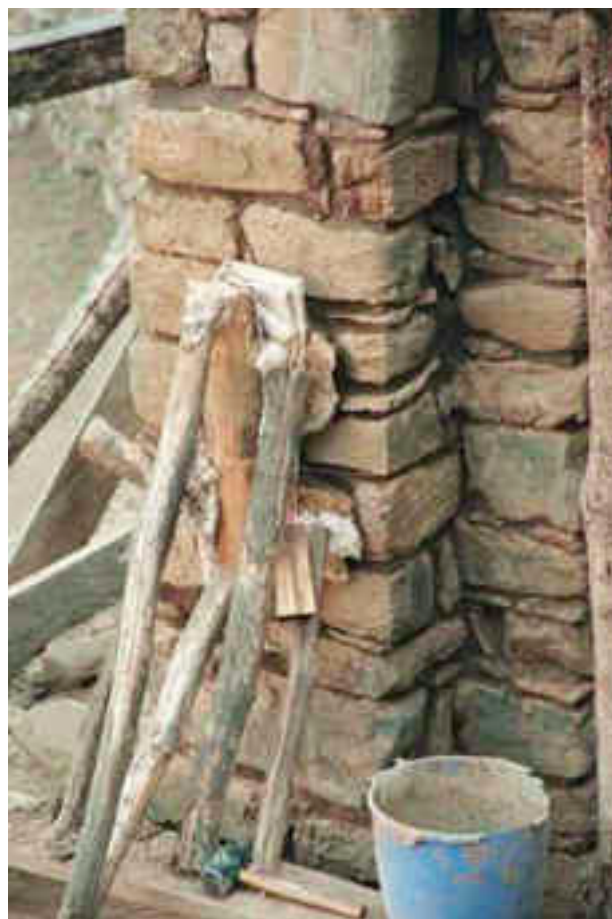
Figura 30. Fragmentos de barro montados en su lugar original y apuntalados por seguridad
