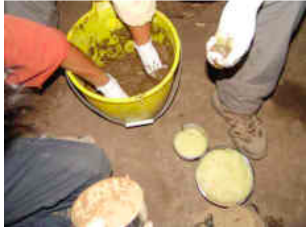
Figura 27. Preparación del mortero de barro utilizando mucílago como aglutinante
