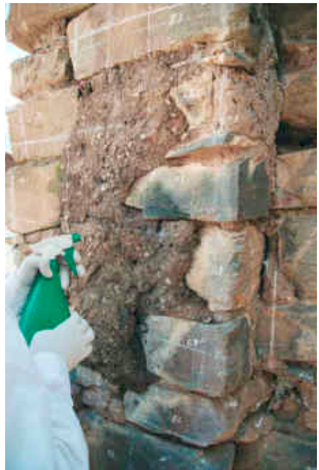
Figura 21. Previa a la ampliación de la colletta italiana, se preparó la superficie del fragmento de barro
