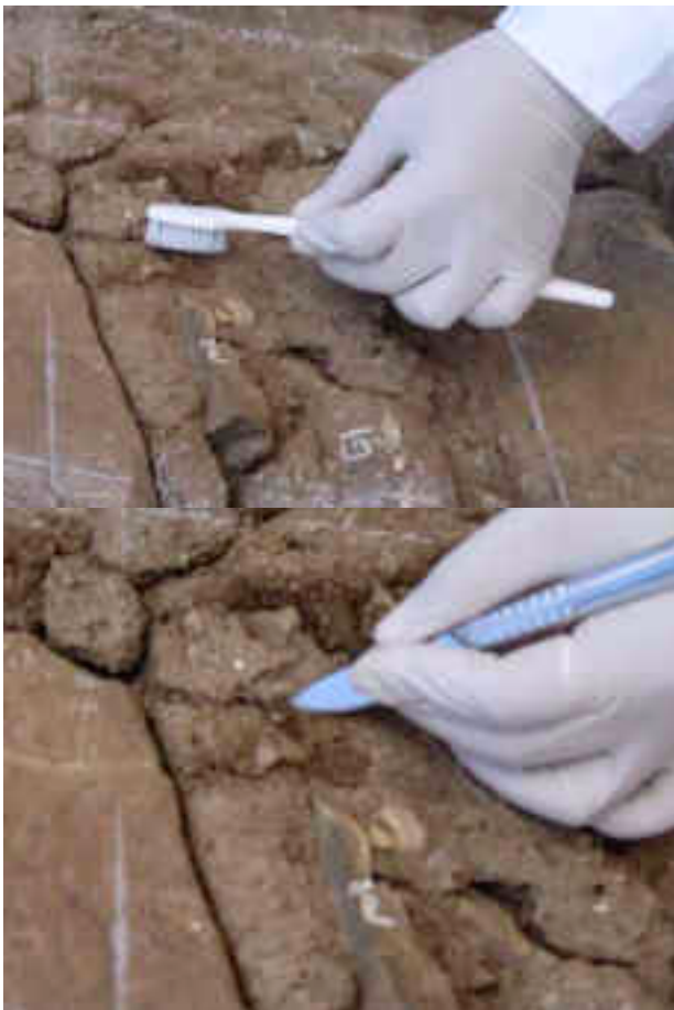
Figura 20. Trabajos de limpieza manual de partículas ajenas al revoque de barro.
