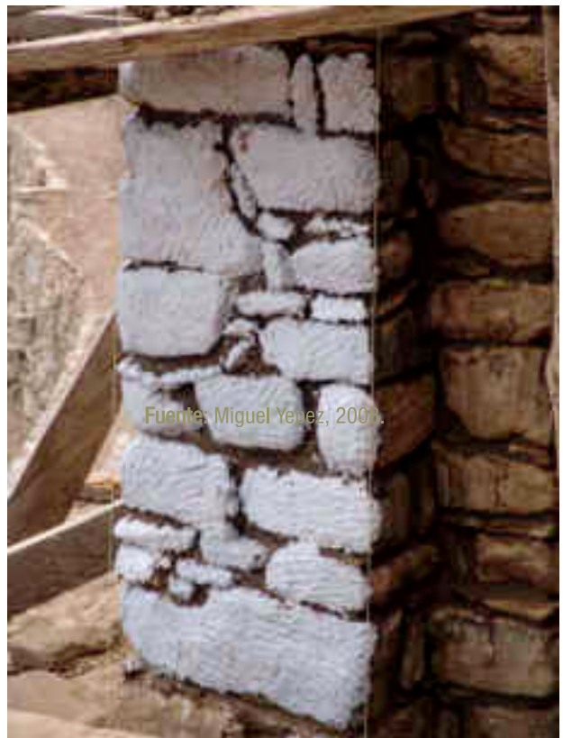
Figura 28. Limpieza de sales en los elementos líticos del muro ya recompuesto
