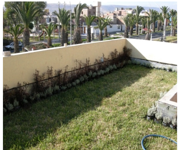
FIGURA N° 05: TECHOS VERDES INSTALADOS EN AZOTEA DE VIVIENDA
