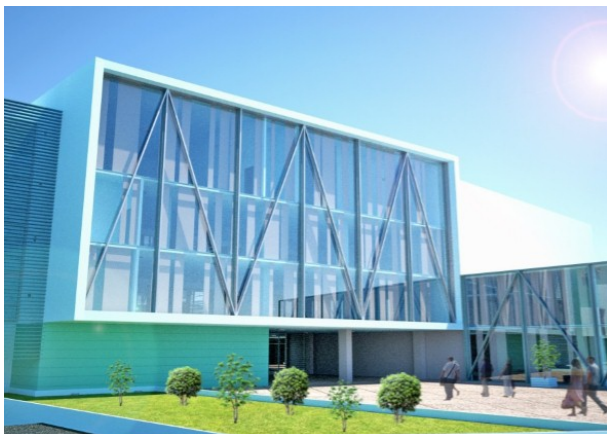
Figura 32. Vista de ingreso hacia Auditorio
