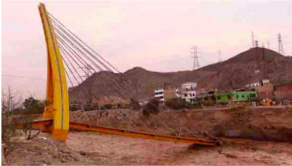
Fotografía 1. Puente de la Solidaridad colapsado
